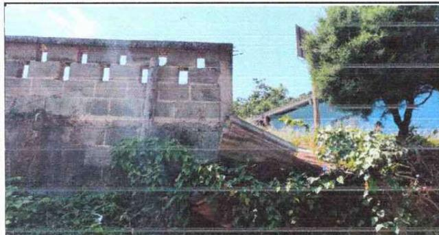
Foto 3: parte del muro de contención deteriorado
